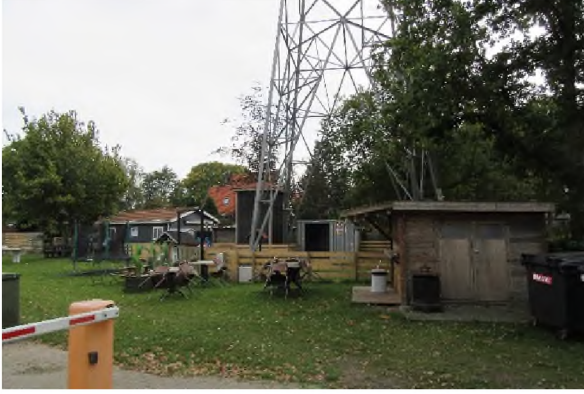
Foto 4.11 | Mast 104 naast de Eendenparkweg
