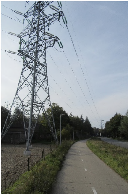
Foto 4.14 | Mast 99 met de Kolbaanweg en zicht op mast 98
