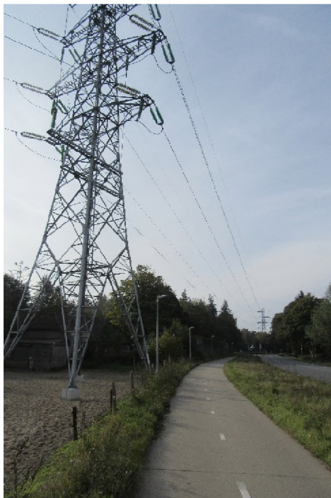
Foto 4.1 | Mast 99 met de Kolbaanweg en zicht op mast 98
