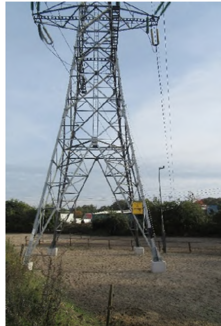
Foto 4.15 | Mast 99 met paardenbak en spoorlijn
