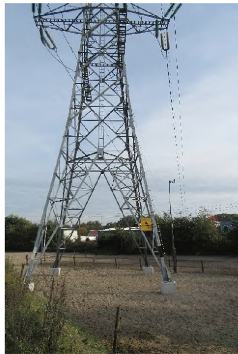
Foto 4.2 | Mast 99 met paardenbak en spoorlijn
