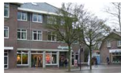
Aaneengesloten gevel rondom plein
