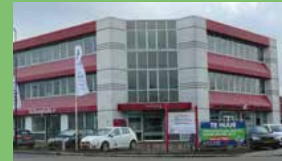
Afwijkend materiaalgebruik van dak en kozijnen (=bijzonder)
