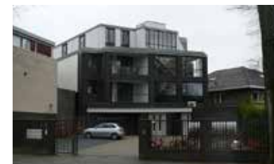
Bouwmasa is niet afgestemd op de naastgelegen bebouwing
