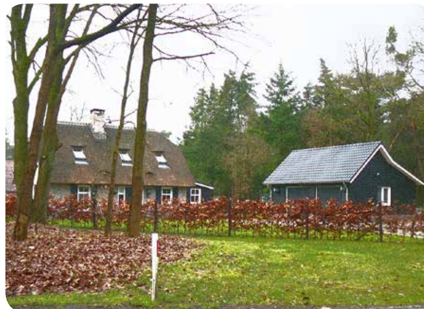
Niet beeldbepalend, gedekt kleurgebruik van het bijgebouw.
