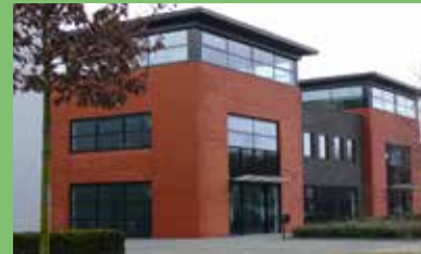
Gevel opgetrokken uit stenen
