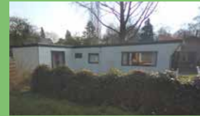
Afwijkend materiaalgebruik van dak en kozijnen (=bijzonder)
