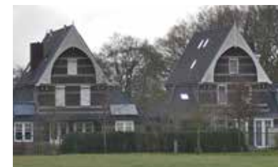
Steil dakvlak met hoge goot (=bijzonder)
