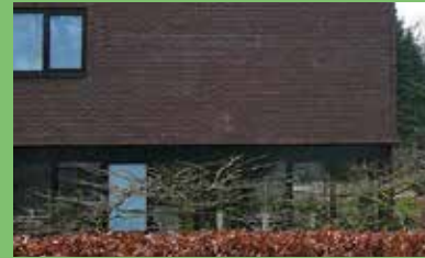
Gevel opgetrokken uit stenen
