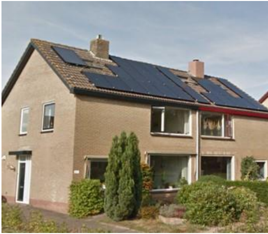
Figuur 6: zonnepanelen geplaatst bij een 2-onder-1-kapwoning
