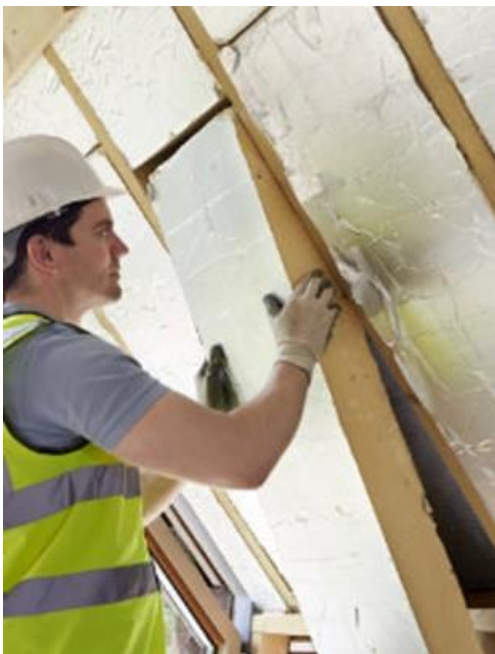
Figuur 4 Toepassing van dakisolatie
